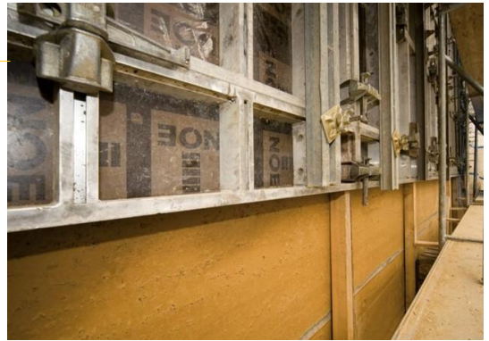
опалубка при изготовления стены LEMtek™
